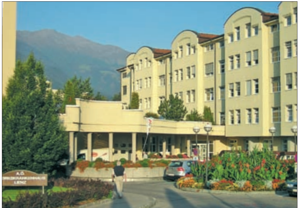
Die Patientenzimmer des alten „Infektionsgebäudes“ wurden durch eine vorgehängte Fassade wesentlich vergrößert und mit eigenen Sanitärzellen ausgestattet.
