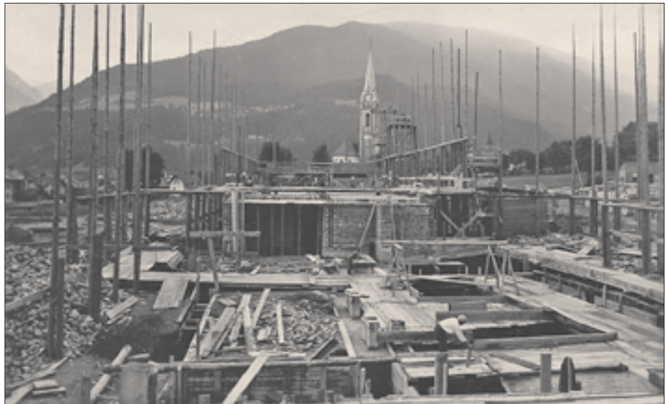
Neubau des Bezirkskrankenhauses: Betonmauerwerk im Heiz- und Kohlenkeller in einer Aufnahme vom 13. August 1929. (Archiv Kneußl, Hall i.T.) Foto: Dina Mariner, Lienz
