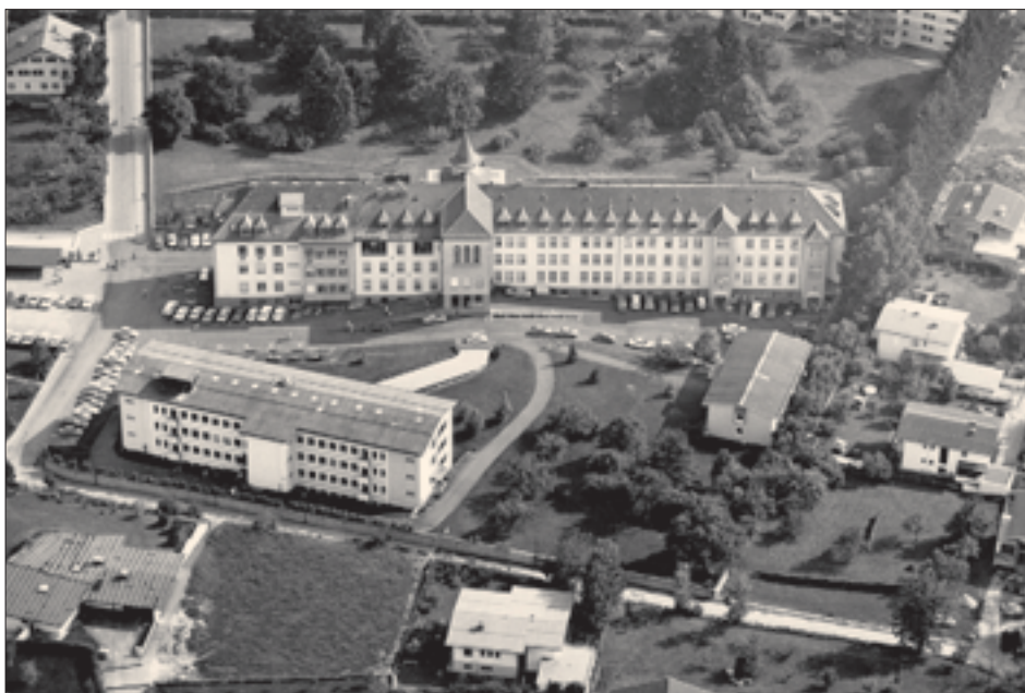
Gesamtansicht des Krankenhauses vor Beginn der Aus- und Umbauten.
