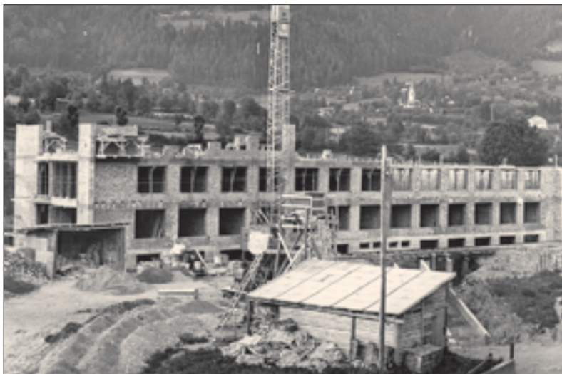
Bau des Infektionsgebäudes (1955/59) als erster Erweiterungsbau nach dem Zweiten Weltkrieg.
