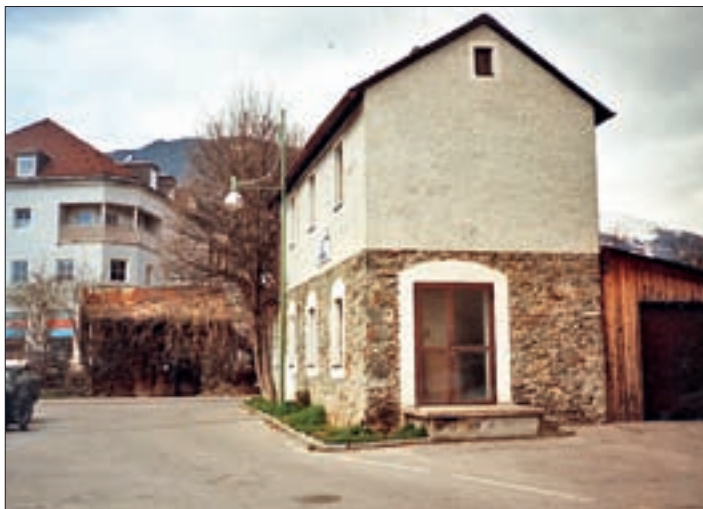
Die ehemalige Erlach'sche Farbmühle am nördlichen Rand des großen Parkplatzes; sie dient heute der Spenglerei Zimmermann als Lagerhaus. Die links dahinter liegende Hütte ist die frühere Lederstampfe der Fa. Wimmer. Foto: A. Heinricher
