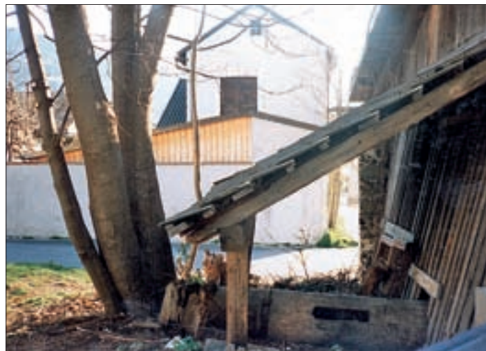
Blick auf die Rückseite der ehemaligen Erlach'schen Farbmühle; rechts die Nordseite der seit vielen Jahren nicht mehr benutzten Lederstampfe Wimmer, vor der der Arbeitskanal der Wiere geflossen ist. Foto: Franz Edlinger
